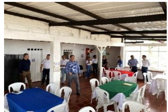
Techo nuevo salón principal
